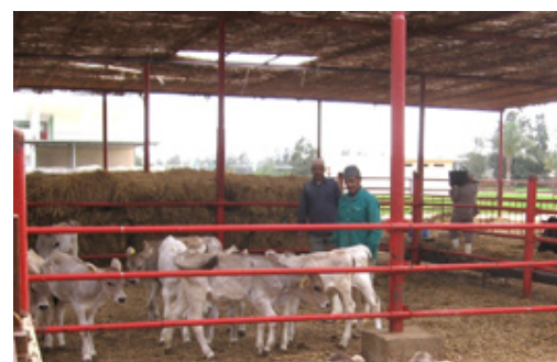
Im neuen Stallgebäude fühlen sich die Kälber wohl
